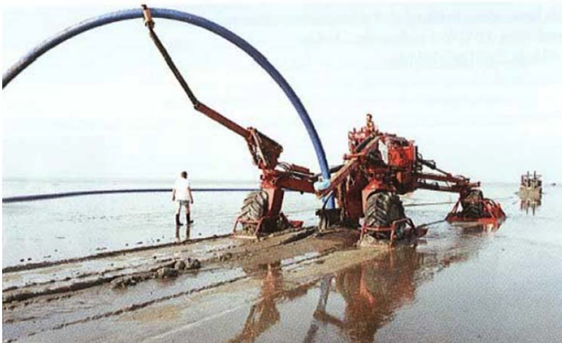
Kabelverlegepflug im Watt Quelle: Busch
